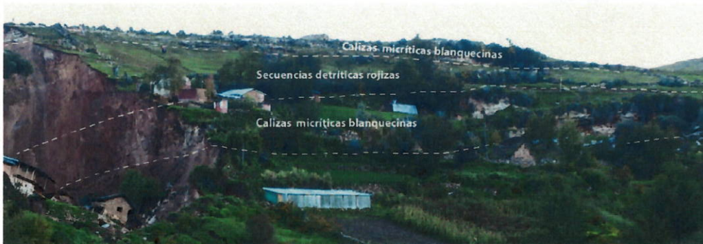
Figura 2. Secuencia estratigráfica local que muestra una intercalación de capas subhorizontales compuestas material detrítico rojizo de matriz arcillosa con capas de calizas amarillentas, en parte alta del centro poblado de Lutto.
