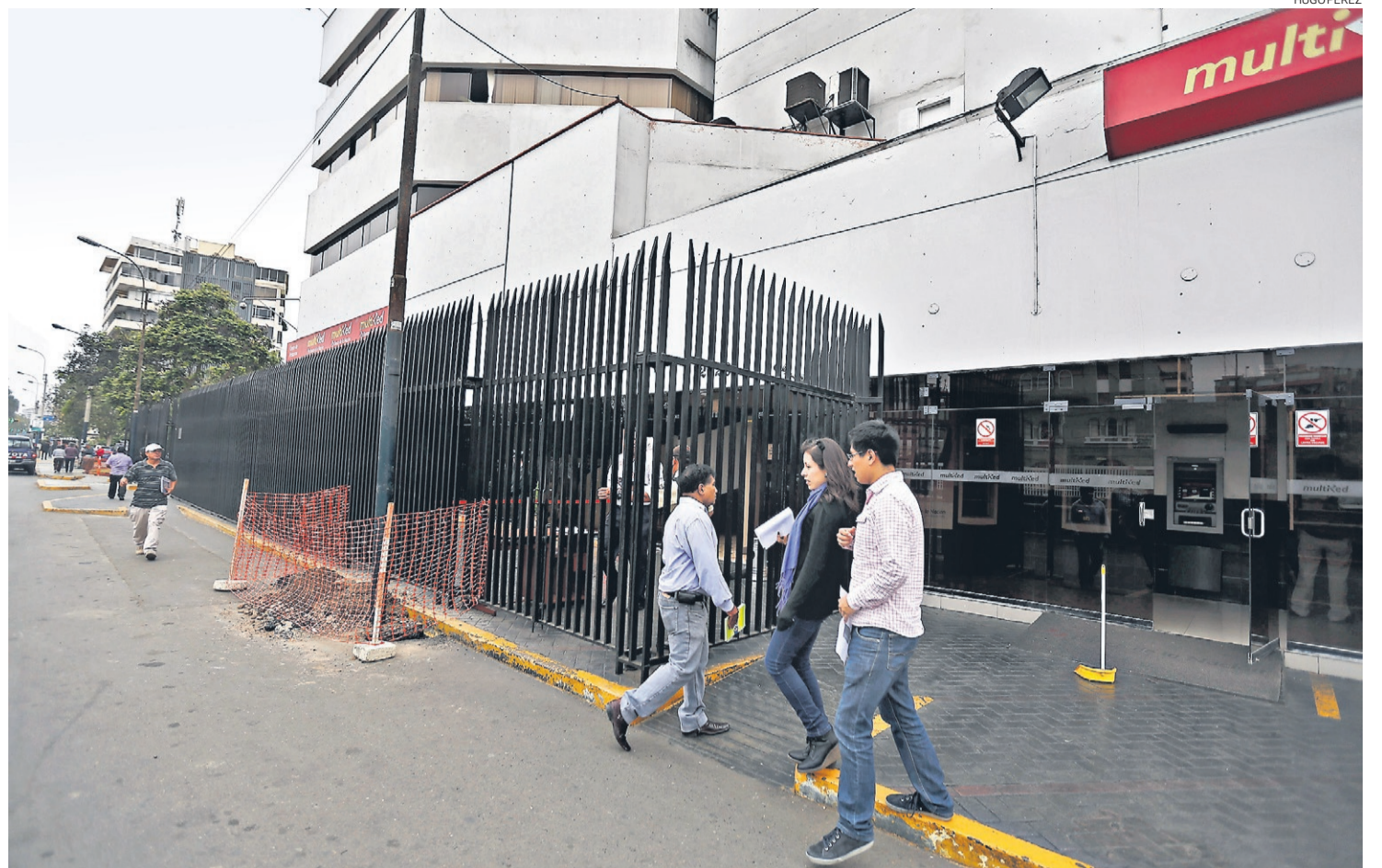
SIN VEREDA. Las personas que caminan por la cuadra 27 de la Av. Arequipa (San Isidro), frente al Banco de la Nación, deben hacerlo por la pista.
